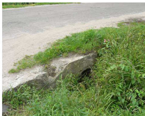
Wylot przepustu
