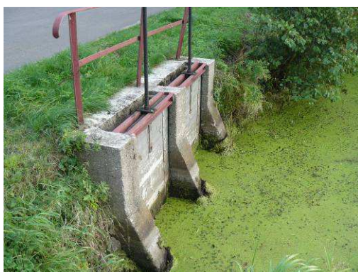
Wlot przepustu
