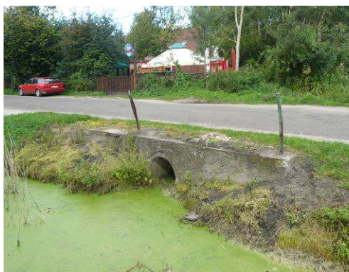
Wlot przepustu
