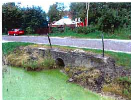
Wlot przepustu
