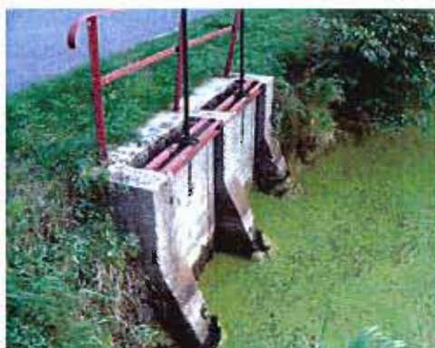
Wlot przepustu
