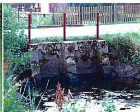
Wylot przepustu
