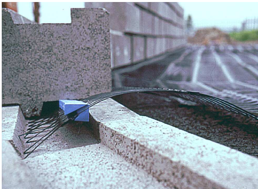
Rys. 5.2.3. Widok ułożonych bloczków i geosiatki z łącznikiem
