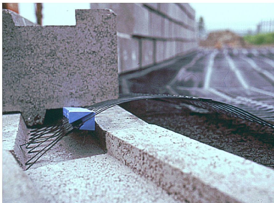
Rys. 5.2.3. Widok ułożonych bloczków i geosiatki z łącznikiem
