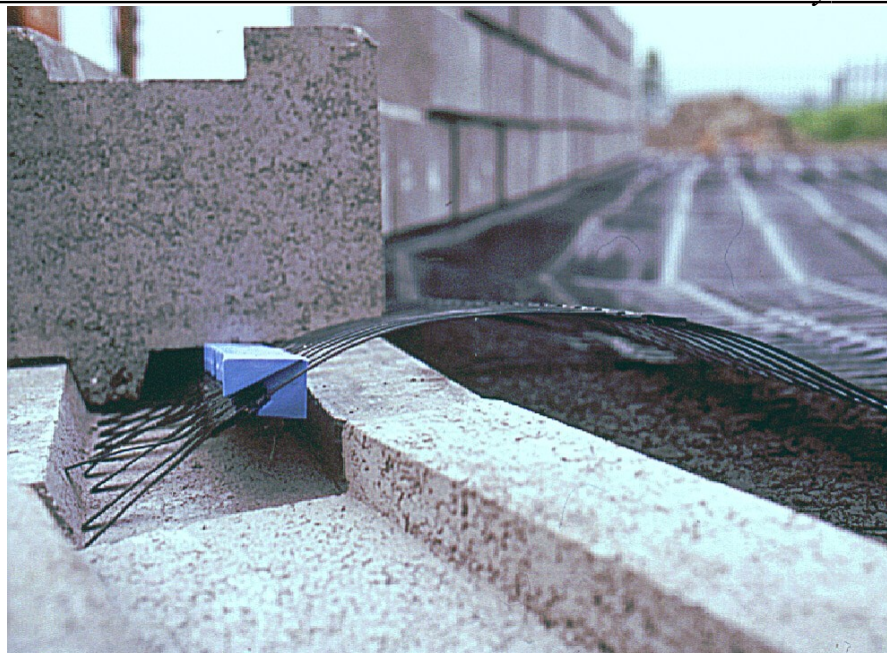
Rys. 5.2.3. Widok ułożonych bloczków i geosiatki z łącznikiem
